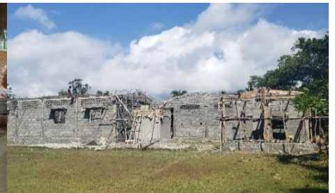
Ecole de Mahatsara en construction
