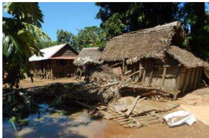
De nombreuses maisons sont détruites
