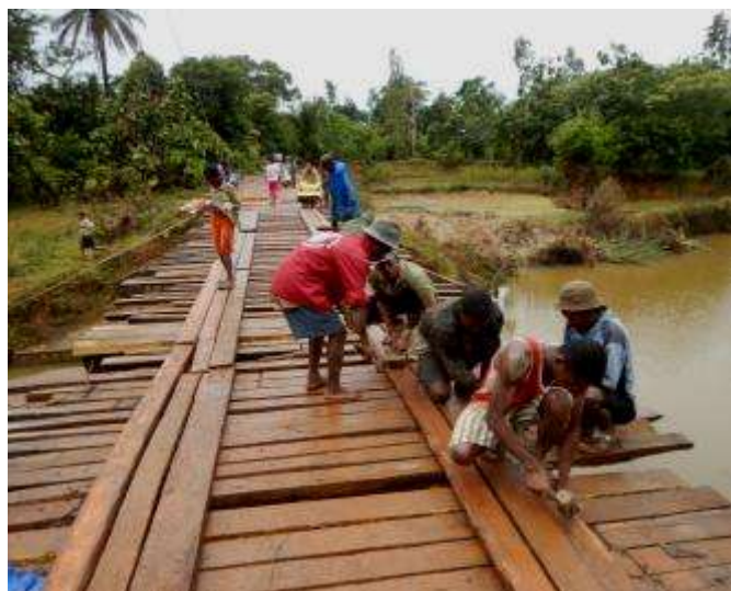
Nous réparons un pont endommagé par le cyclone
